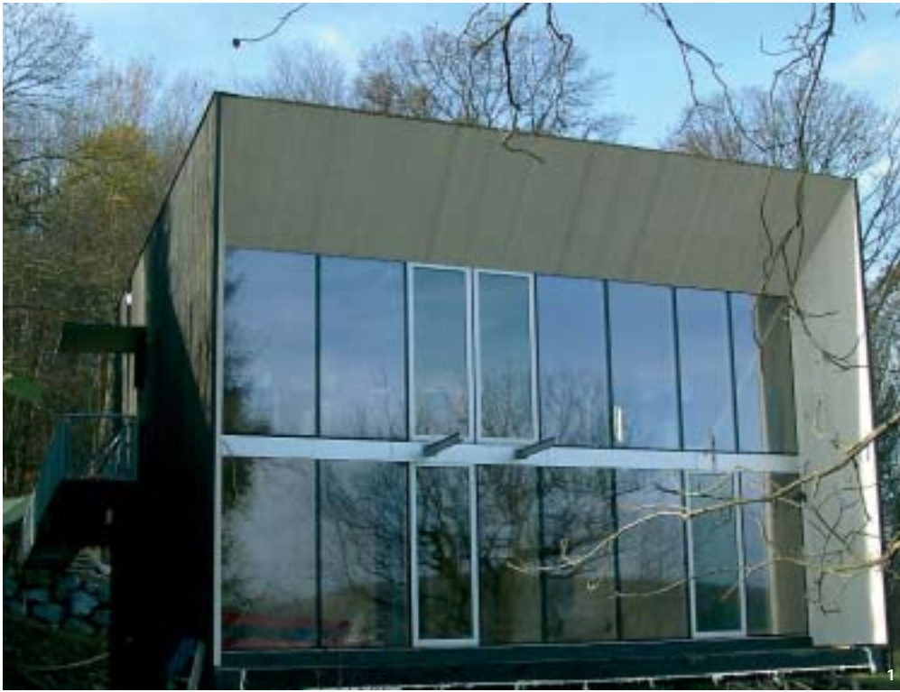
1 Im Kompetenzzentrum wurde an Themenbereichen mit hohem Zukunftspotenzial geforscht. Im Bild: Holz-Glas-Verbundelemente im Praxiseinsatz
