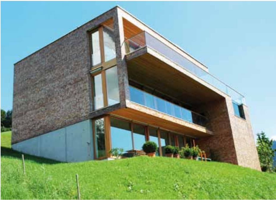
3 Große Fensterflächen und die vorgeschriebene Winddichtheit erfordern intelligente Lösungen für ein angenehmes Raumklima.
