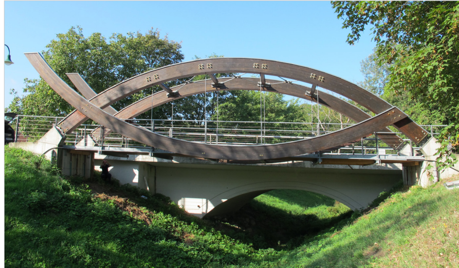
Brücke mit oberseitiger Abdeckung auf den gebogenen Brettschichtholzträgern
