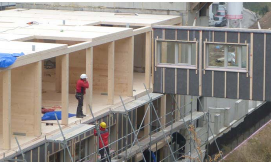
Die Holzbautechnik sowie die Haustechnik werden im Vorfertigungsgrad zulegen. Der Vorteil der Vorfertigung liegt vor allem in der kürzeren Bauzeit.
