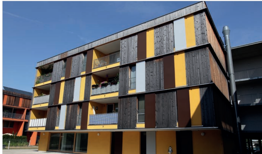
Laut Hermann Atzmüller werden vor allem die klimapolitischen Herausforderungen durch den Holzbau lösbar sein.
