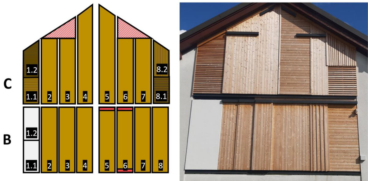
Abbildung 8: Übersicht und Codierung der konstruktiven Varianten auf der Westseite des Forschungshauses.
