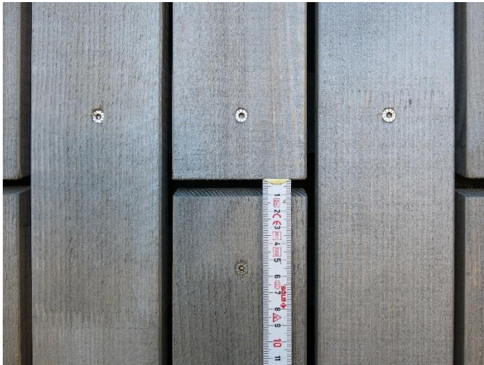
Abbildung 37: Fassade mit offenen Fugen mit ca. 10 mm Breite, in denen die schwarz gestrichenen Traglatten nicht erkennbar sind
