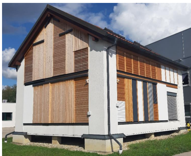
Abbildung 9: Forschungshaus der Holzforschung Austria mit den untersuchten Holzfassaden: Westfassade (giebelseitig; konstruktive Varianten) und Südfassade (Farbvariationen).
