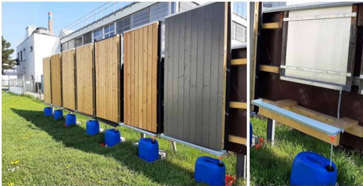
Abbildung 5: Coole-Hülle-Fassadenprüfstand auf den Freigelände der Holzforschung Austria. Links: Sieben Testvarianten, das Beregnungswasser wurde über die Brandschutzblech-Elemente in die Auffangbehälter geleitet. Rechts: Blindwert, das Beregnungswasser wurde ausschließlich über das Brandschutzblech-Element aufgefangen und in den Auffangbehälter geleitet.
