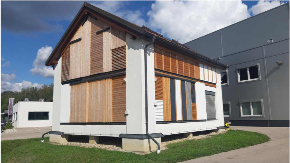
Abbildung 3: Süd-West Ansicht des Forschungshauses nach dem Umbau mit den Farbvariationen auf der Südseite und den konstruktiven Variationen auf der Westseite.
