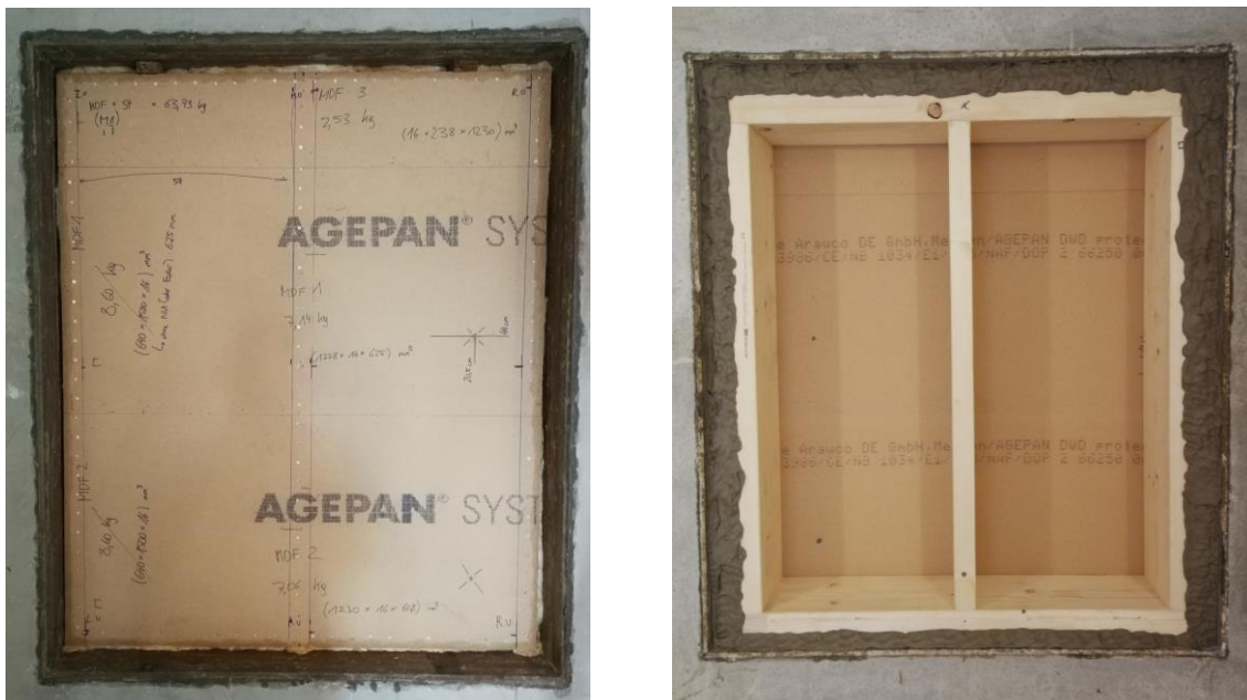
Abbildung 14: In der Fensteröffnung eingebaute Holzrahmenwand. Links: Verkeilung des Prüfkörpers; Die umlaufende Fuge wurde anschließend mit Mineralwolle ausgestopft und mit Fensterkitt abgedichtet; Ansicht aus dem Senderaum. Rechts: Der Luftraum zwischen Prüfkörper und empfangsraumseitig größerer Laibung der Fensteröffnung wurde mit Trittschalldämmung ausgefüllt und mit Fensterkitt abgedichtet.
