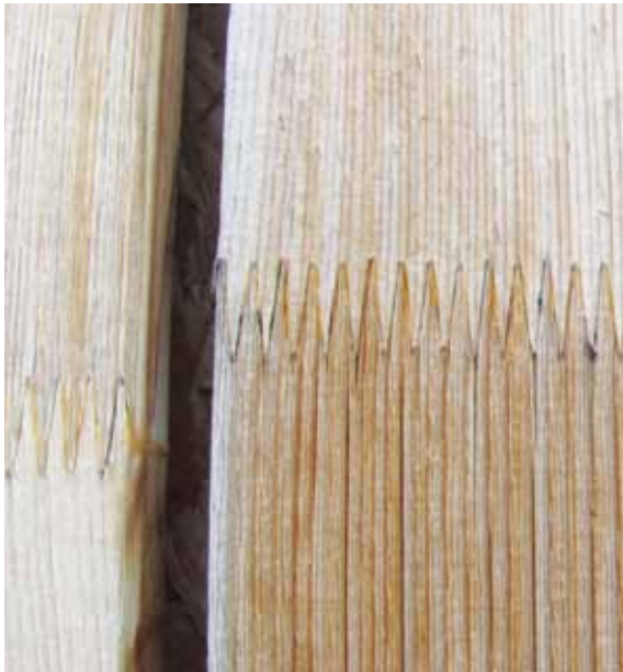
Intakte Keilzinkung an senkrechten Fichtenbrettern nach acht Jahren Bewitterung
