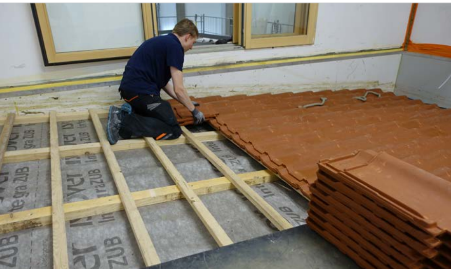
Verlegen von Verschiebeziegeln auf dem zu untersuchenden Dachaufbau.
