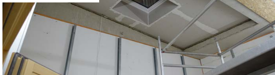
Innenansicht der Öffnung mit eingebautem Dachflächenfenster und Außenansicht des untersuchten Fensters mit Dreischeiben-Isolierverglasung (links oben)
